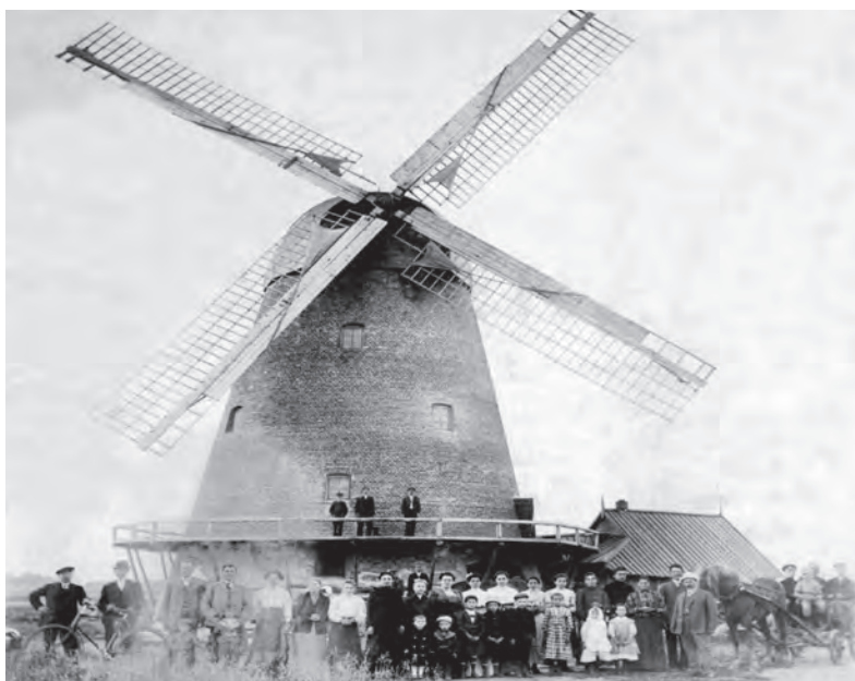
Żurle na Litwie. Dziadek Jan Kusznerewicz z rodziną, koniec budowy młyna w 1906 roku
